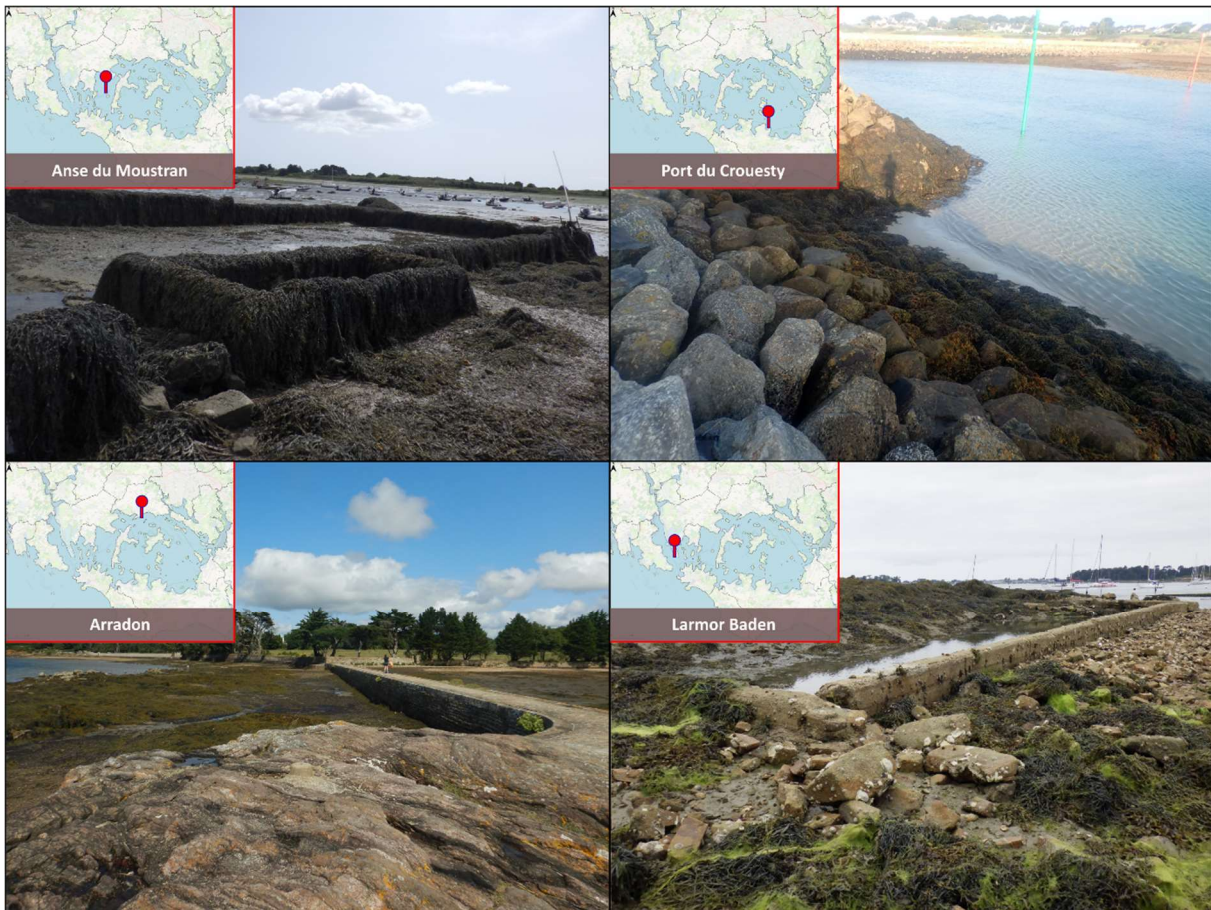
Figure 143. Illustrations des structures artificielles observées dans l'aire d'étude. En haut de gauche à droite : bassin ostréicole et digue portuaire. En bas de gauche à droite : jetée et muret (© TBM environnement, 2024).
