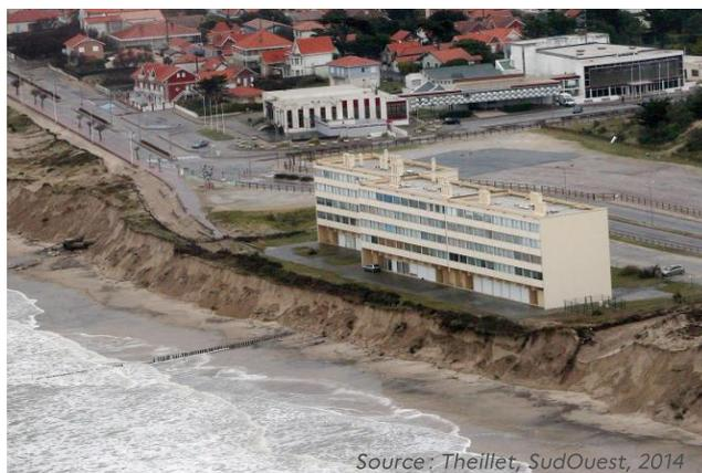
**Figure 35** : L'immeuble "Le Signal", au bord de l'effondrement dû à l'érosion de la côte
