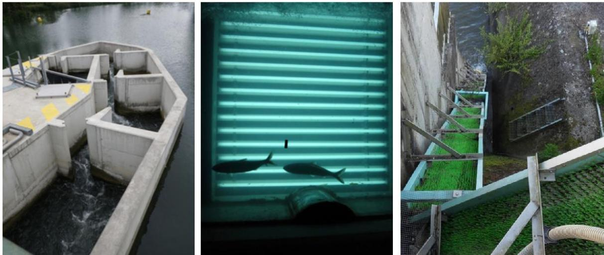
**Figure 10 : (de gauche à droite) : la passe à bassins successifs de Crouin, le dispositif de vidéo-enregistrement et une rampe à anguille**
