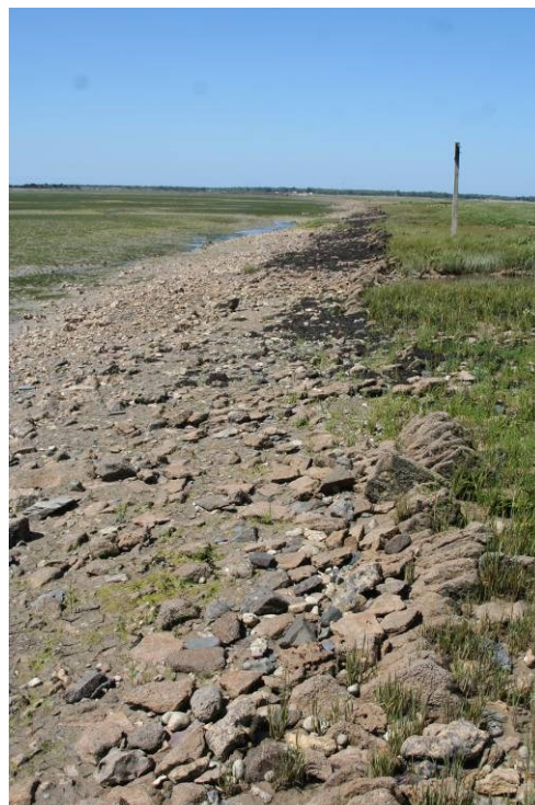
Photo 3 : Ancienne digue de la prise du Coursoir à marée basse.
