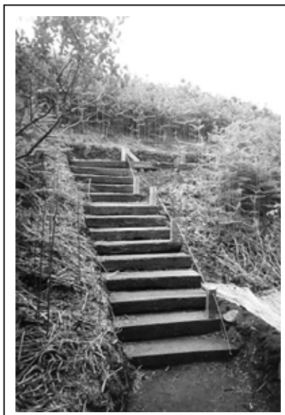
Escalier monofilé, en traverses de chemin de fer. Evacuation latérale des eaux de ruissellement, amélioration du confort de marche et consolidation du sentier sur le secteur en pente. (réal. Syndicat des Caps)
