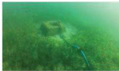
Système de mouillage de Bretagne Plongée: revêtement textile de la ligne (AFB, 2016)
