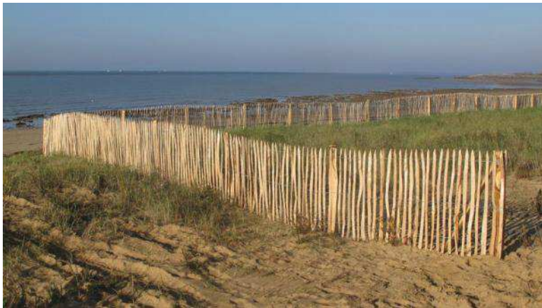
Aménagements de ganivelles sur la Pointe de l'Aiguillon (PNR Marais Poitevin, 2012)
