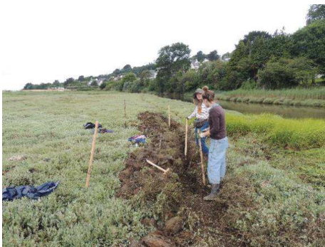
Creusement de tranchée - © A. Larzillière
