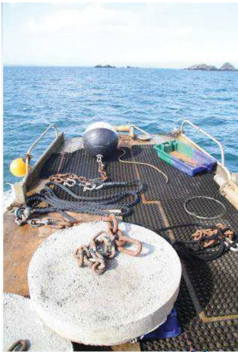
Préparation du système de mouillage et de la bouée avant installation en mer (LPO, 2015)
