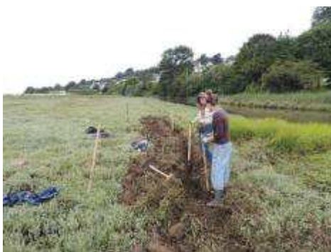
Creusement d'une tranchée A. Larzillière / PNR Armorique
