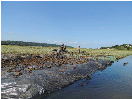
Pose de bâches - © A. Larzillière
